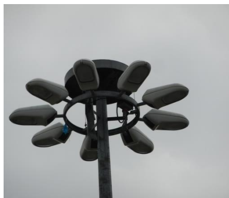
Figura 24 – Suporte tipo coroa para 9 luminárias – Av. Brasília – Conj. Cristina
