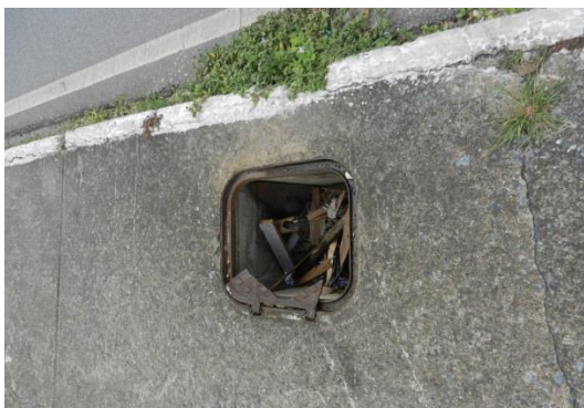
Figura 32 – Tampa da caixa de passagem quebrada – canteiro central da Av. Brasília – Conj. Cristina
