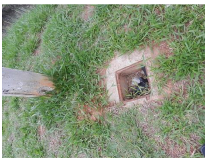
Figura 34 – Caixa de passagem sem tampa – Pr. Catumbi
