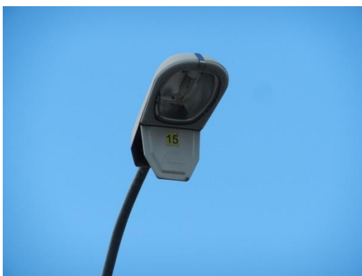
Figura 33 – Tampa do compartimento para equipamento auxiliar aberta - na Av. Paranapanema – São Benedito
