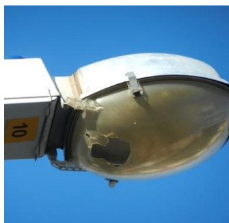
Figura 29 – Refrator em policarbonato quebrado – Rua Machado de Assis - Londrina
