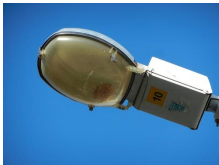
Figura 30 – Refrator prismático depreciado – Rua Gonçalves Dias – Londrina
