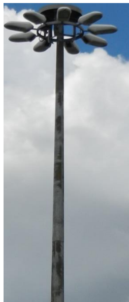
Figura 7 - Luminária fechada com refrator poli curvo – Av. Brasília
