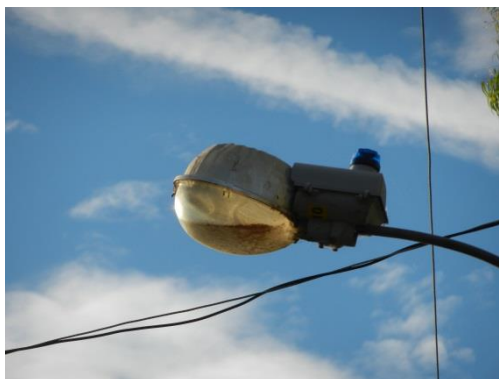
Figura 31 – Refrator captando e acumulando água de chuva – Av. das Azaleias – Duquesa II
